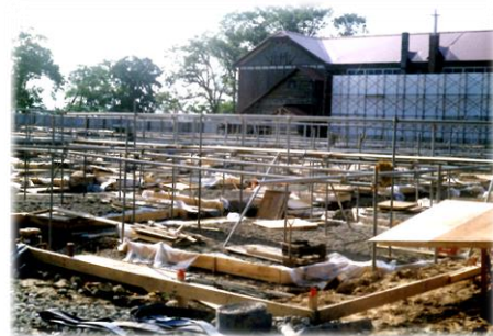
【音江小校舎建築時の様子】*後方は旧校舎
