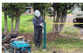
鉄棒の切断の様子
