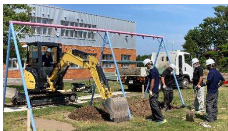
固い地盤を掘り起こしていただきました
