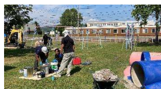
コンクリート部分の修繕
